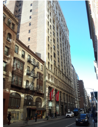
Hauptgebäude der NSSR, 16th St.
