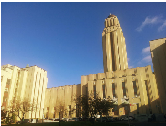
Der Pavillon Roger-Gaudry ist mit seinem 22 Meter hohen Turm von überall auf dem Campus zu sehen.
